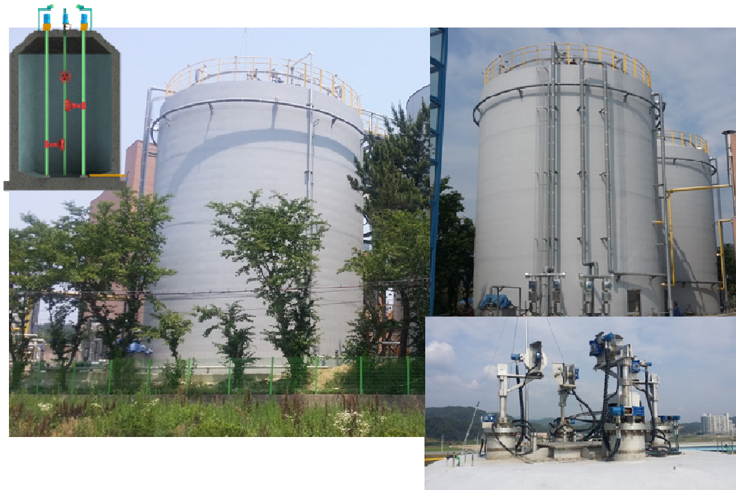
울진군 환경순환형 가축분뇨병합처리 설치사업 공사 중
